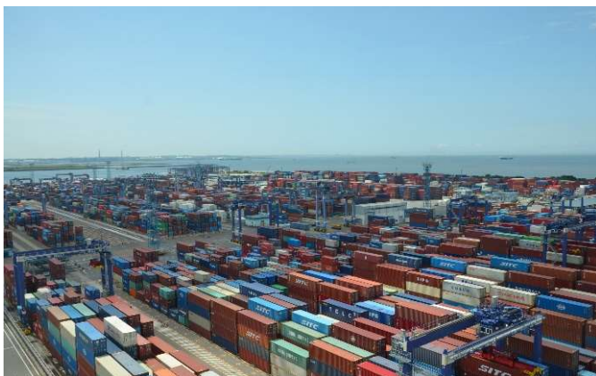
遠隔操作・電動RTG
